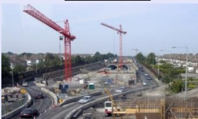
Travaux entrée de Casablanca
